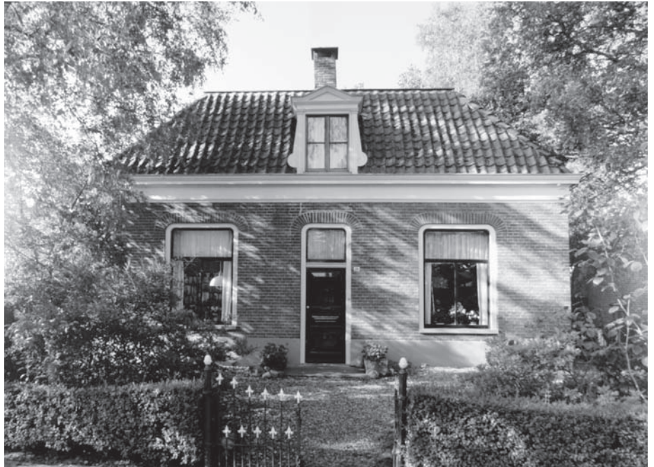
▲ Het huis aan de Zwolscheweg tegenover de openbare lagere school, gebouwd in 1880, waar meester Loman vele jaren heeft gewoond.
